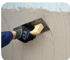
Colocación de las placas
