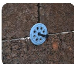
Aplicación de masilla térmica
