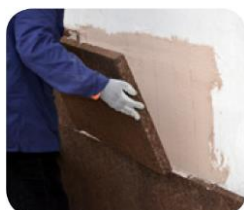
Fijación de las placas
